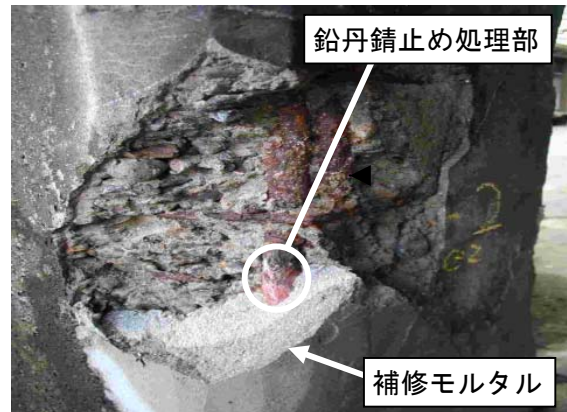
写真-10 鉛丹錆止め補修
