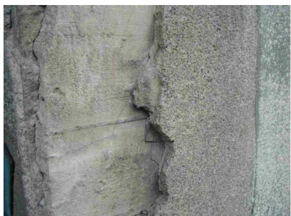
写真-6 洗い出し仕上げ
