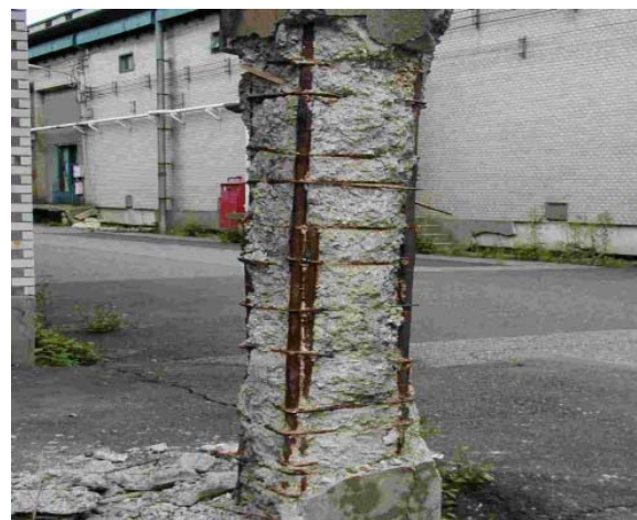
写真-4 ひび割れ柱はつり後
