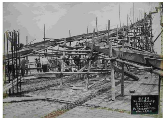
写真-1 コンクリート打設状況
