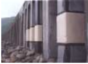
写真 - 1 雷電施工時
