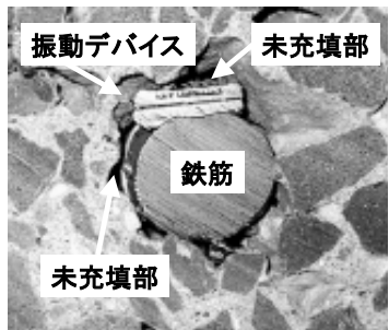
写真-4 粗骨材2倍コンクリート
