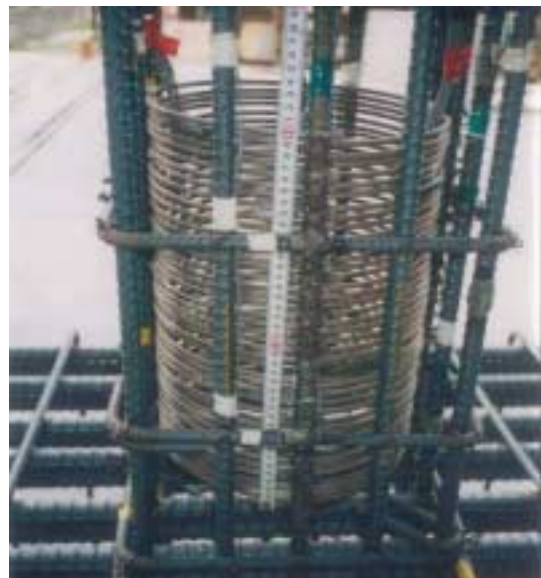
写真-1 内巻帯鉄筋配筋状況
