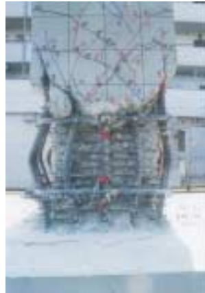
写真-3 RCK-2 載荷終了
