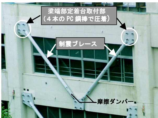
写真-1 制震補強工法の実施例
