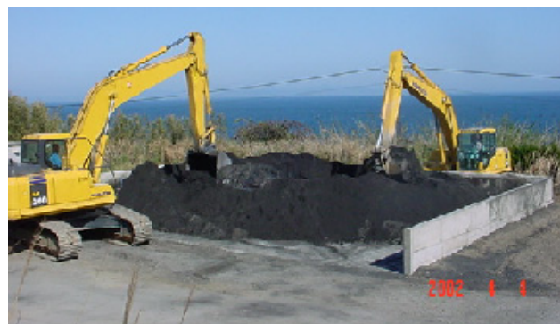
写真-1 練混ぜ状況
