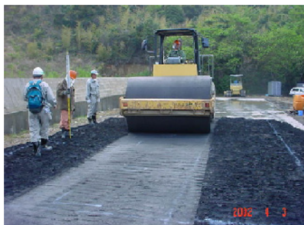
写真-2 締固め状況
