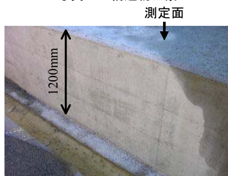
写真-2 底版の状況
