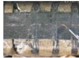
写真-1 直交方向CFS貼付試験体の破壊状況の一例 (M-1-4)
