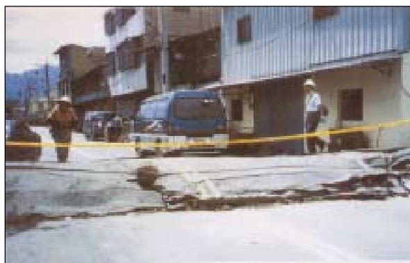
図-4 長庚大橋橋台部の損傷状況
