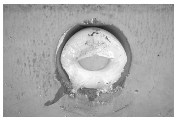
写真-1 継手の破壊状況
