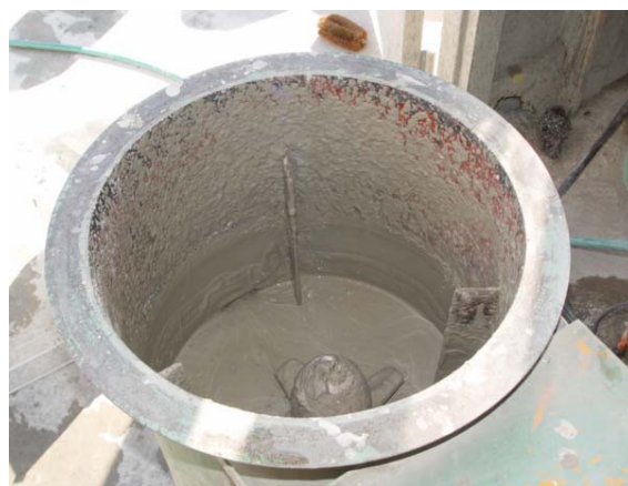
図－2 練混ぜ槽内の様子
