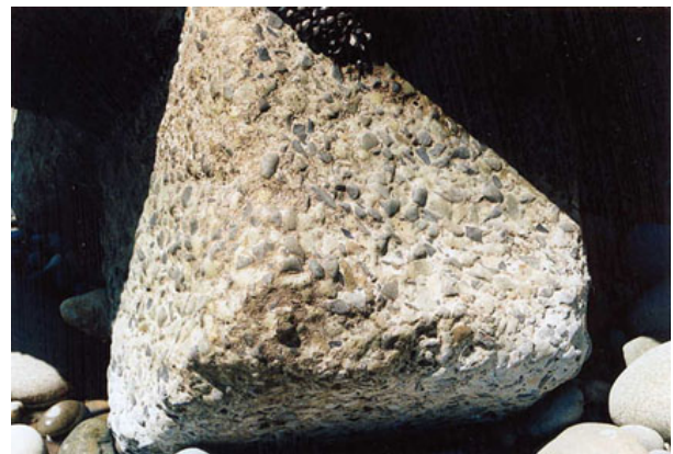
写真—5 既設5トン六脚ブロックの磨耗状況
