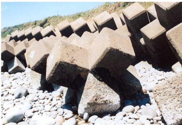
写真—5 既設5トン六脚ブロックの磨耗状況
