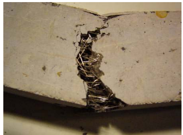
写真-2 UFRC 供試体表面の鋼繊維の状況(促進腐食試験 10 サイクル後, Cl^- = 13kg/m^3 )
