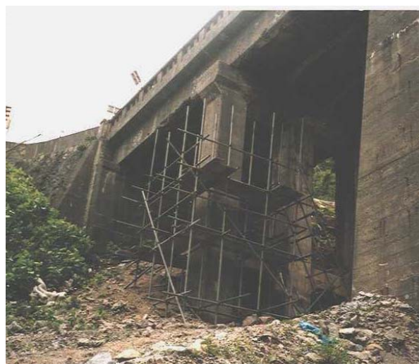
写真-1 脱塩工法適用構造物(1993年)
