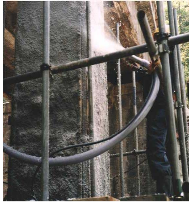
写真-2 仮設陽極の設置
