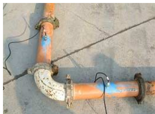
図-2 圧力センサー設置状況
