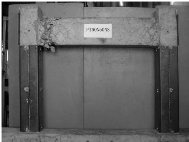
写真-1 試験体の破壊状況
