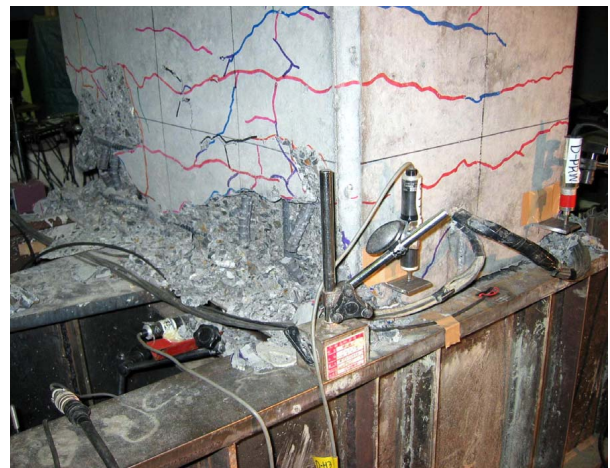
写真-3 実験終了後の供試体の損傷状況
