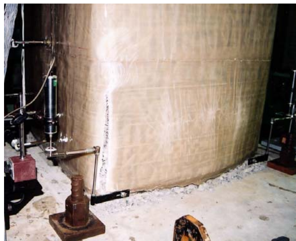
写真-2 VFRP の損傷状況
