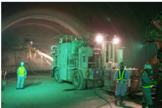
写真 - 2 吹付け試験実施状況
