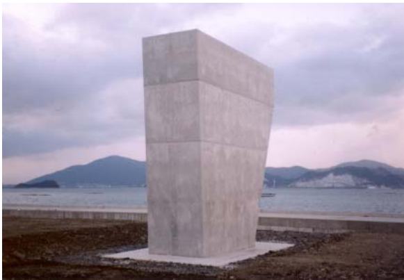
写真－5 橋脚の施工事例（福岡県新北九州空港連絡道路建設事務所提供）
