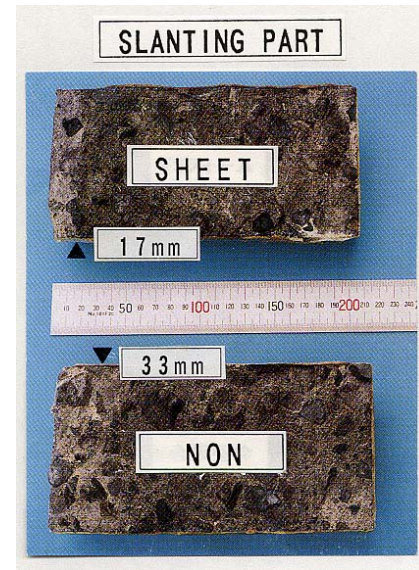
写真-4 塩化物イオン浸透性の改善
