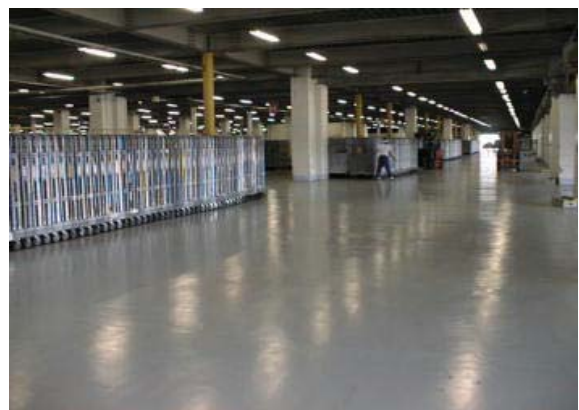
図-12 施工後の床スラブ（村松委員提供）
