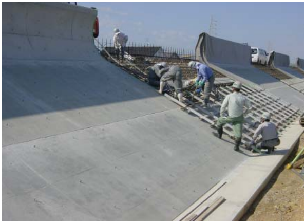
写真－7 河川堤防波返部への適用例（野々目委員提供）
