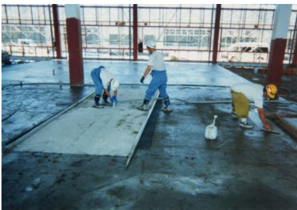
写真-11 脱水処理（村松委員提供）
