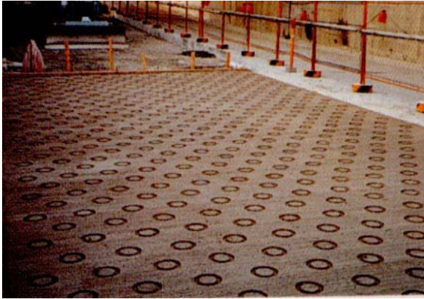
写真-9 スロープ車路への適用（村松委員提供）
