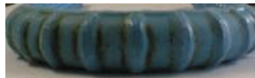
写真-7 暴露面加工の腐食状況 (塩水噴霧 25 サイクル)
