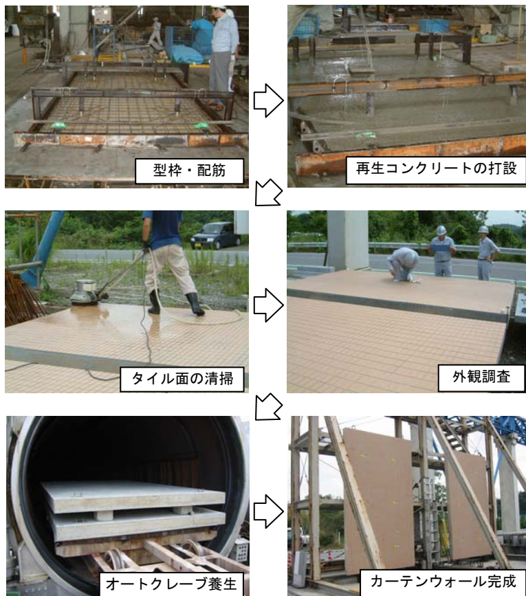
写真-1 PCa カーテンウォール試験体の製作状況
