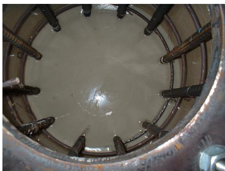
写真-1 型枠内部
