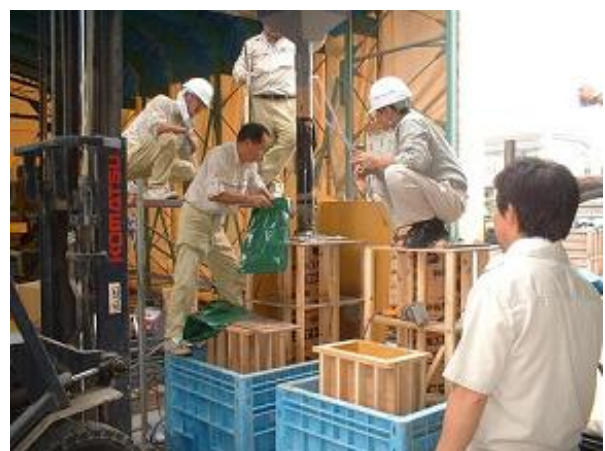
写真-3 コンクリート打設
