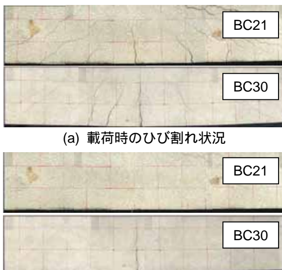
(b) 除荷時の残留ひび割れ状況
