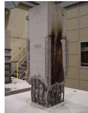
(f) 補強鋼板撤去後
