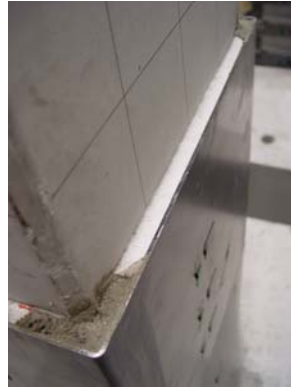
(e) 試験終了後 モルタル充填状況
