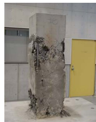
(f) 補強鋼板撤去後
