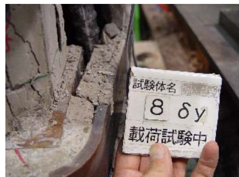
写真-3 定着部材損傷状況
