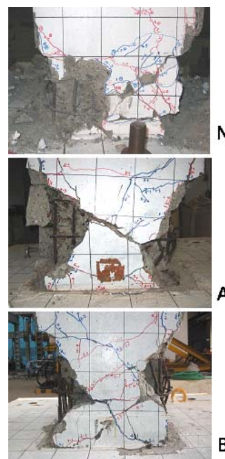
写真-1 柱基部の損傷状況（載荷試験終了時）
