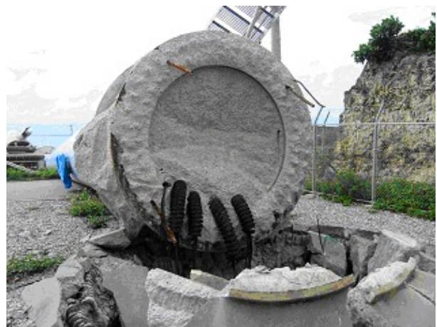
(b)風車倒壊(底面)
