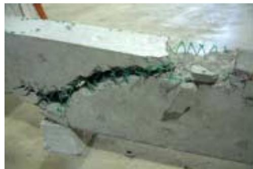
写真-3 斜めひび割れ周辺のネットの定着状況
