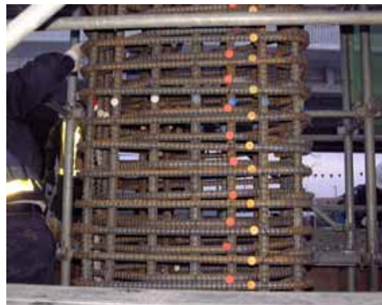
写真-1 過密配筋の例
