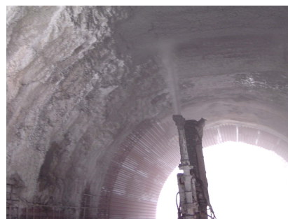
写真-4 頂部付近への施工状況
