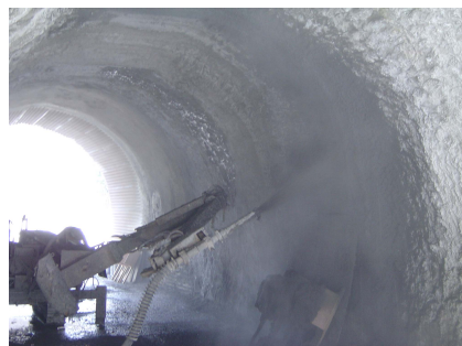
写真-3 HFSC の吹付け試験状況
