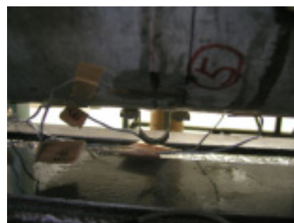
写真 - 4 パイ型変位計設置状況
