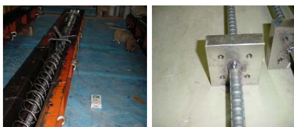
写真-1 スパイラルフープの 設置・溶接された端板
