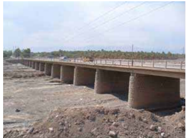
写真 - 1 橋梁全景写真 ( 橋梁 No.1 )
