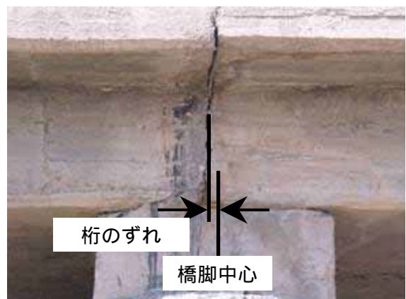
写真 - 2 P1 橋脚以外の橋脚上の掛違い部
