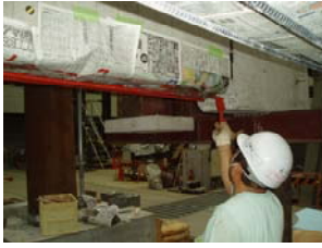
(a) 防錆剤塗布状況 (b) 上向き施工状況 写真 - 1 修復供試体作成状況
