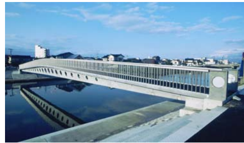
写真-1 酒田みらい橋 (UFC 橋)
