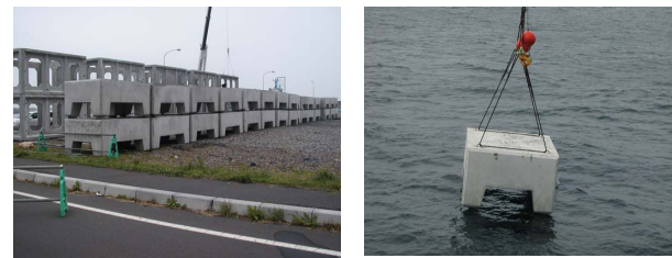
写真-5 施工状況
