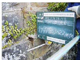
写真-3 橋脚近傍の壁石部に発生したひび割れ 写真-4 橋脚上面アスファルトのひび割れ
