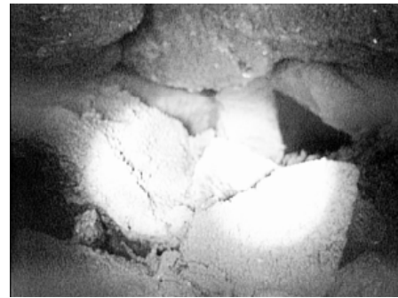
写真-5 内視鏡による中詰土の状況写真
