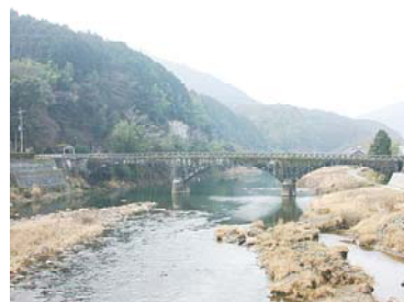
写真-1 羅漢寺橋の外観
