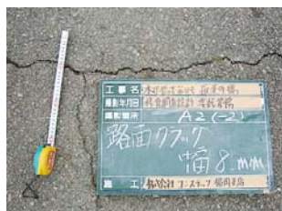
写真-3 橋脚近傍の壁石部に発生したひび割れ 写真-4 橋脚上面アスファルトのひび割れ
