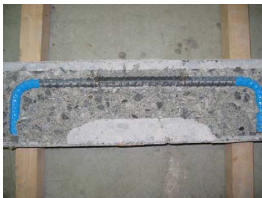
写真-4 鉄筋取り出し状況
