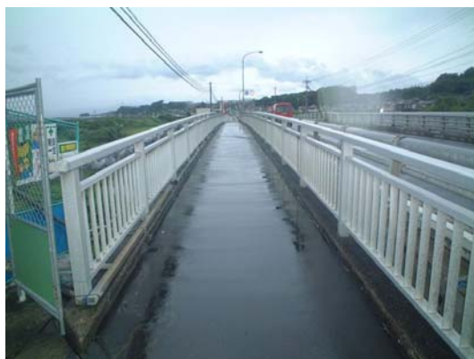
写真-1 鈴田橋側道橋の外観
