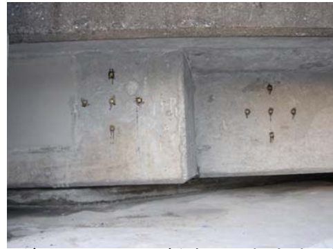
(b) ダイヤフラム及び主桁への標点貼付状況
