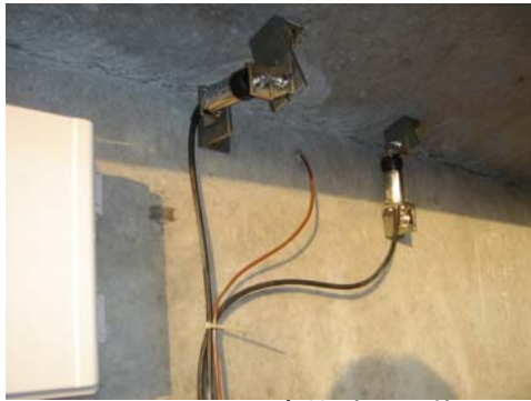
(a) ハンチへの変位計設置状況
