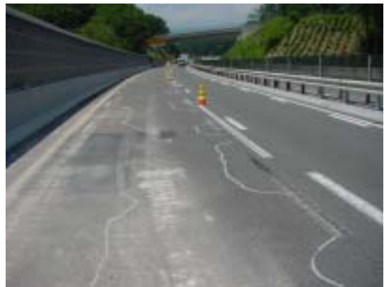
写真-2 たたき点検後の舗装状況
