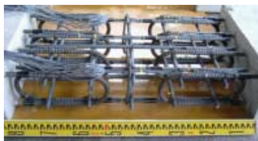
写真－1 打継ぎ部の配筋（20φ）
