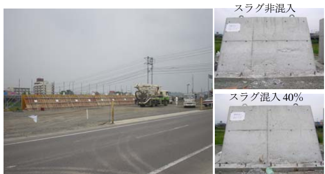
写真-2 フィールド試験の施工および脱型後の状況
