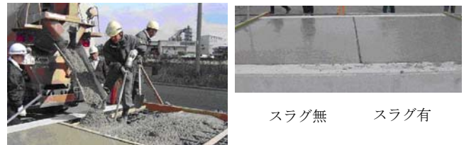
写真-3 コンクリートの打設および仕上り状況
