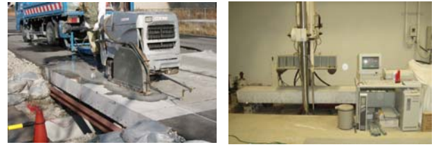
写真-4 RC 梁の切取りおよび載荷試験状況
