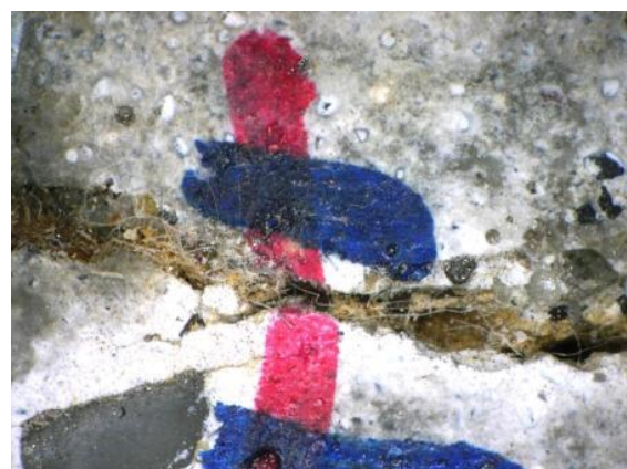
写真-4 ひび割れ幅 0.4mm の通水試験体上面 (配合 2 通水開始後 28 日目)
