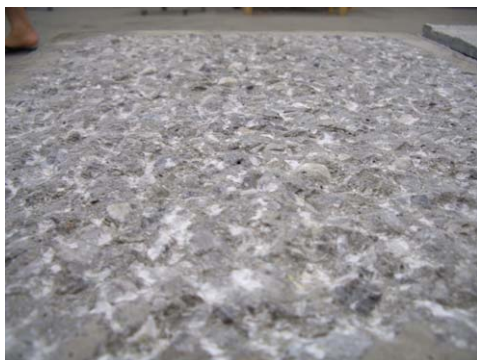
写真-6 「はつり仕上げ」の表面性状
