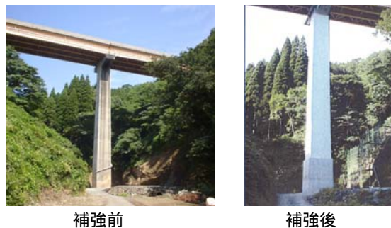
写真 - 8 鹿島橋全景
