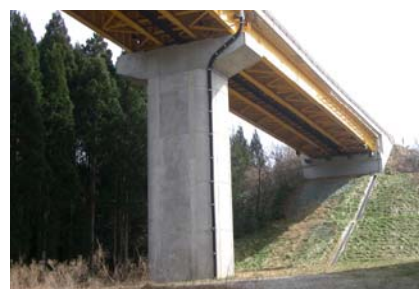
写真 - 4 安津見高架橋全景（補強後）
