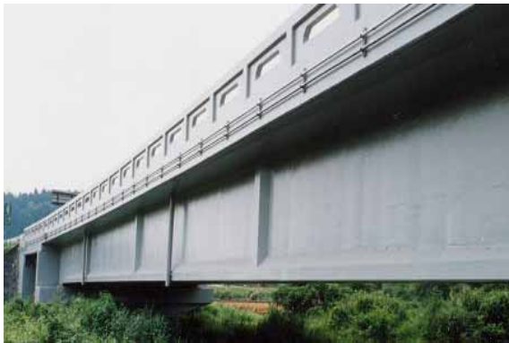
写真 - 4 ポステン PC 耳桁への表面塗装処理
