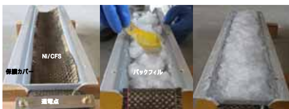
写真 - 3 陽極ユニットの製作
