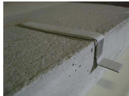
写真-2 陽極接続材の形状
