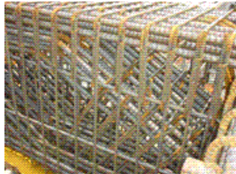
写真－1 部材接合部の高密度配筋例 (鋼材量 350kg/m 3 , 鋼材の最小あき 50mm 未満)
